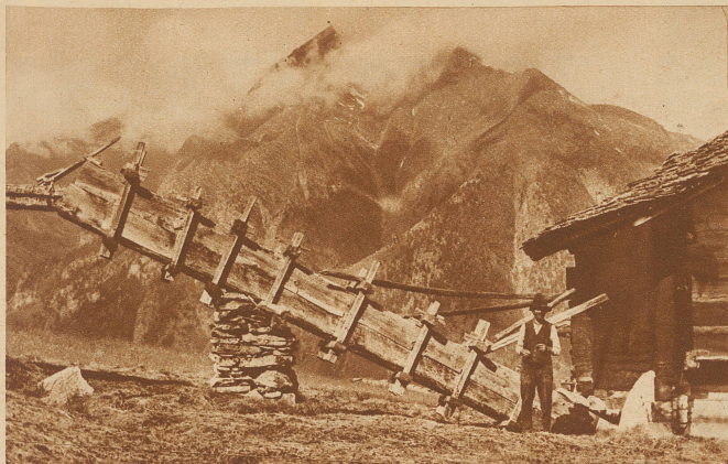
Hölzerne Druckleitung zu einer Walliser Getreidemühle
