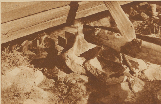
Turbinenrad einer Mühle im Wallis
