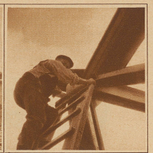
Kranenarbeiter in luftiger Höhe
