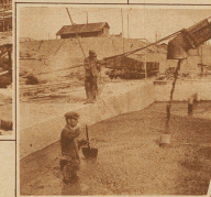
Betonieren der Schleusensole. Die Schleusensole erhält eine Platte von 1 m Dicke. Es wird solange Beton zugeführt und vereilt, bis das Schwarz der eingrammten Platte verschwindet
