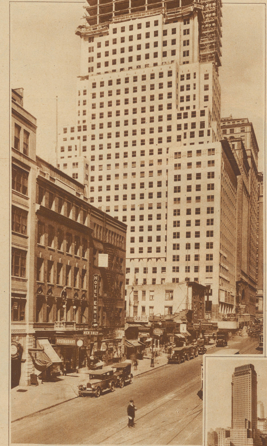
Am 16. Juni. Die Stahlkonstruktion hat schon beinahe die endgültige Höhe erreicht. Am unteren Teil des Baues, der in wenigen Tagen bezugsbereit ist, sind alle Gerüste verschwunden.
