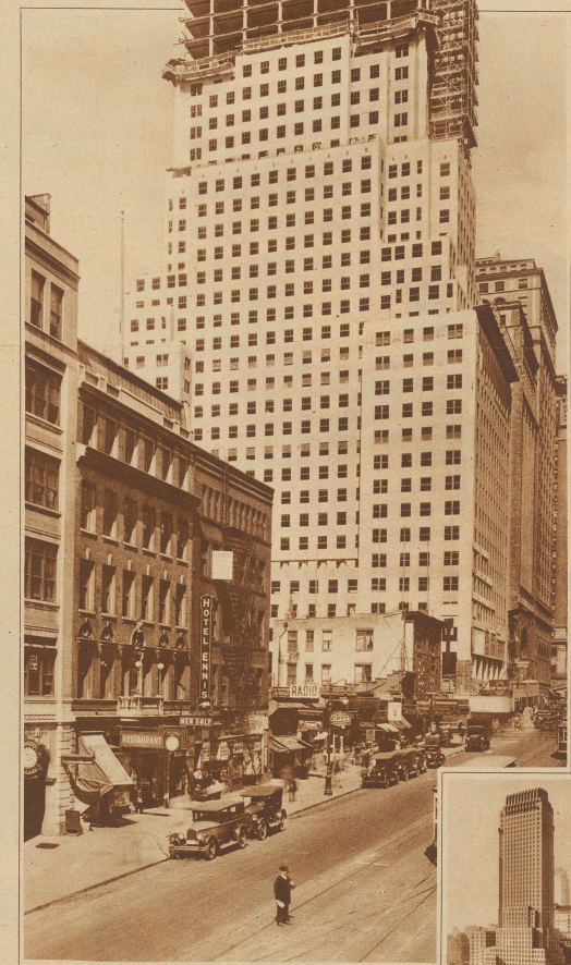
Am 16. Juni. Die Stahlkonstruktion hat schon beinahe die endgültige Höhe erreicht. Am unteren Teil des Baues, der in wenigen Tagen bezugsbereit ist, sind alle Gerüste verschwunden.
