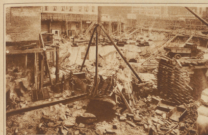
Am 3. Januar. Mit Dampfschufeln, Derricks und komprimierten Bohrern haben die Arbeiter ihren Weg bis 50 Fuß unter dem Straßenniveau in die Granitfelsen von Manhattan gebahnt. Es ist bekannt, daß Manhattan Island eine Felseninsel ist, und daß lediglich der Felsenuntergrund den Bau der riesigen Wolkenkratzer mit 60 und mehr Stockwerken ermöglicht.
