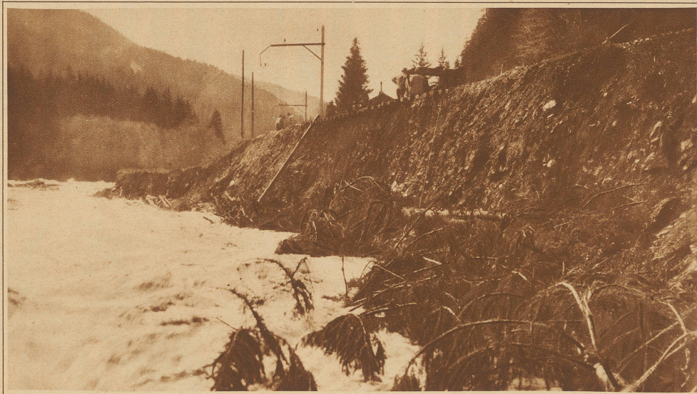
Hochwasser der Simme bei Grubenwald (Berner Oberland). Der Damm ist bis unter den Bahnkörper weggerissen (Phot. R. Wenger)
