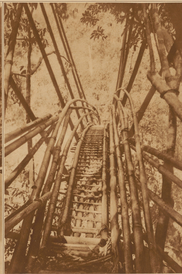
Eine gewölbte Bambusbrücke, von Negern Zentralafrikas erbaut
