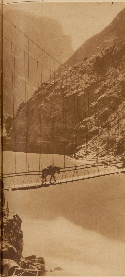
Hängebrücke über einen Fluß in Kanada. Infolge der geringen Tragfähigkeit werden die Maultiere einzeln über die Brücke geritten
