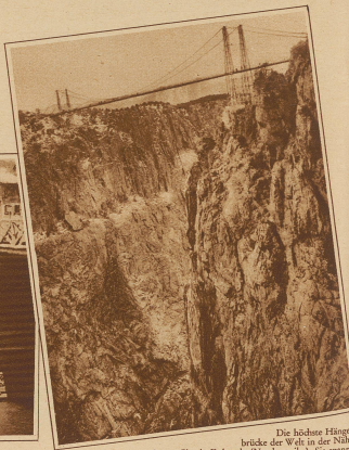
Die höchste Hängebrücke der Welt in der Nähe von Canon City in Colorado (Nordamerika). Sie spannt sich in einer Höhe von 320 m über den Royal Georgefluß. Die Spannweite von Träger zu Träger beträgt 270 m, die ganze Länge der Brücke 380 m
