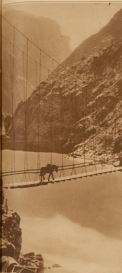
Hängebrücke über einen Fluß in Kanada. Infolge der geringen Tragfähigkeit werden die Maultiere einzeln über die Brücke getrieben
