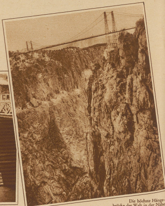
Die höchste Hängebrücke der Welt in der Nähe von Canon City in Colorado (Nordamerika). Sie spannt sich in einer Höhe von 320 m über den Royal Gorge-Fluß. Die Spannweite von Träger zu Träger beträgt 270 m, die ganze Länge der Brücke 380 m
