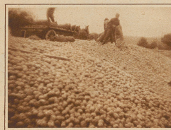
Das riesige Obstlager einer Großmolkerei
