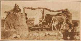
Primitives Schöpfrad zur Bewässerung der Felder
