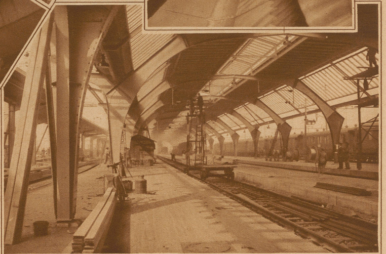
Bild links: Das Bahnsteigdach geht seiner Vollendung entgegen
