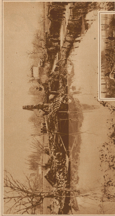
Die weggerissene Hängebrücke über den Agoutt bei St. Sulpice. Die Fluten standen hier mehr als 20 m über dem normalen Pegel
