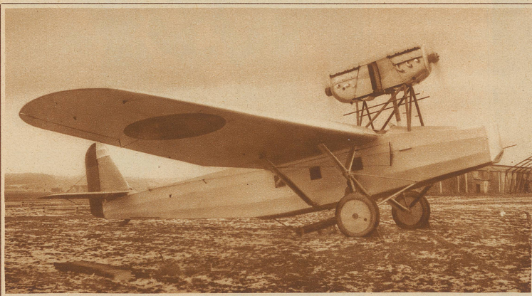
Ein schweizerisches Großflugzeug. Die Flugzeugfabrik Alfred Comte in Horgen ließ letzten Samstag in Dübendorf die ersten erfolgreichen Versuchsflüge mit dem Bombenflugzeug A. C. 3 ausführen. Diese Maschine rein schweizerischer Konstruktion ist in Serie an die bolivianische Regierung zu liefern. Die Kanzel vorne am Flugzeug ist als Geschützturm gedacht und soll zum Einbau eines Schnellfeuergeschützes dienen. Im Rumpf sind besondere Vorrichtungen für die Bombenladung angebracht (Phot. Wild)
