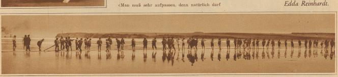
Ausschleppen des längsten See-Fernsprechkabels der Welt, das zwischen Finnland und Schweden gelegt wurde
