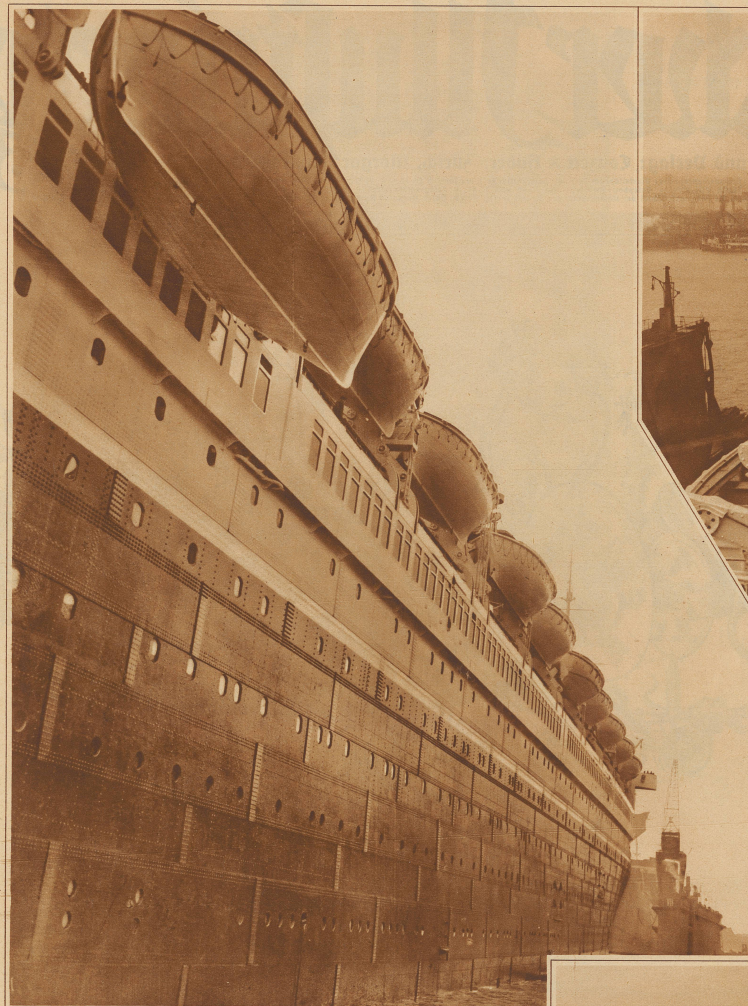
Ein Teil der unsinkbaren Rettungsboote des Dampfers «Europa». Fassungsvermögen 145 Personen. Alle Boote haben Motorantrieb
