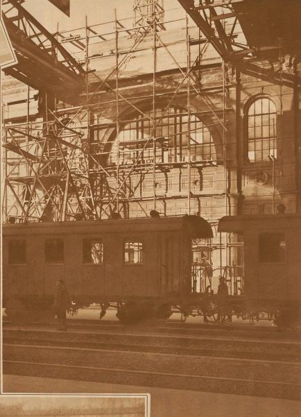
Umbau im Zürcher Hauptbahnhof. Abbruch des alten Daches, das durch ein neues ersetzt wird
