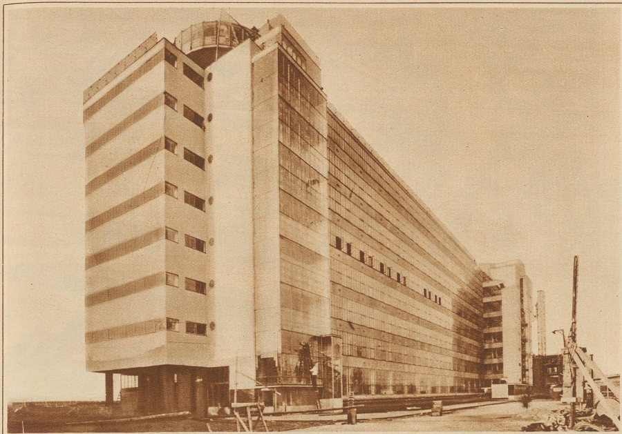
Bild links nebenstehend: Eine Fabrik aus Glas in Rotterdam. Die Sachlichkeit ist vorbildlich. Besonders interessant sind die Aufbauten der Dachanlage, auf welcher sich ein Teerraum für die Angestellten befindet. Das ganze Haus ist eine einzige Fensterfläche, so daß die Räume von allen Seiten lichtüberflutet sind
