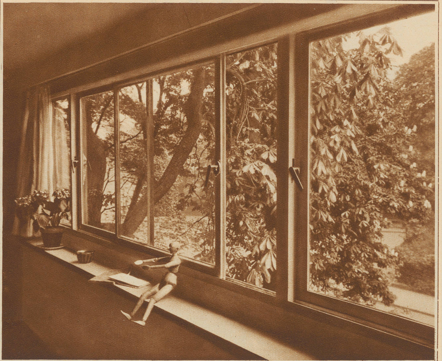
Fensterwand des Hauses Cook in Boulogne s. S., erbaut von Le Corbusier. Es entspricht der Außenwand eines Hauses, die frei vorkragt und nicht trägt, sondern selbst von dem Eisenbetongerüst im Innern des Hauses getragen wird, daß sie an Stelle von Mauerpfellern eine durchgehende Fensterwand besitzt. Und es entspricht unserm Verlangen nach Licht und Verbundenheit mit der übrigen Welt, daß uns eine Fensterwand mehr Freude macht als Mauerpfeller
