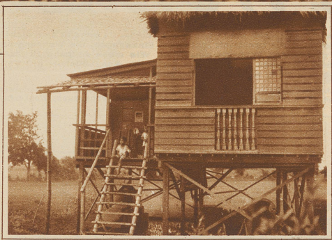
Hier macht sich schon der amerikanische Einfluß geltend. Die Wände sind aus Brettern gezimmert; selbst ein Stück Treppengeländer fand dabei Verwendung
