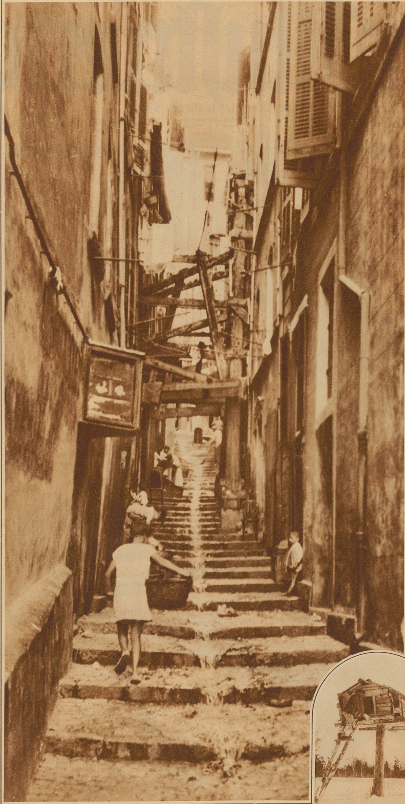
Marseille. Häuser der Altstadt, vom Einsturz bedroht
