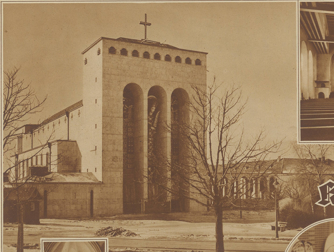
Die Frauenfriedenskirche in Frankfurt a. M., vollständig in Beton ausgeführt, ist ein Beispiel für das heutige Streben nach neuen Bauformen
