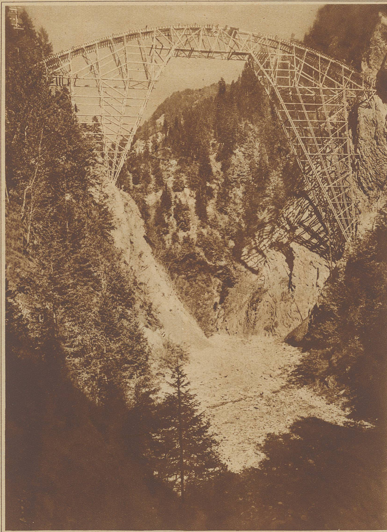
Das Gerüst der Salginabrücke, die Schiers mit dem Bergdörfchen Schuders verbinden wird. Sie ist ein Beweis dafür, wie man sich in Graubünden bemüht, der Entvölkerung der Gebirgstäler entgegenzuarbeiten. Erbauerin ist die bekannte bündnerische Brückenbaufirma Coray
