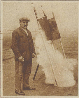
Auf dem Flugplatz Le Bourget bei Paris hat man in diesen Tagen wegen starken Nebels und schlechter Sicht Versuche mit neuartigen Signal-Raketen gemacht, die dem Flieger das Auffinden des Landungsplatzes erleichtern sollen
