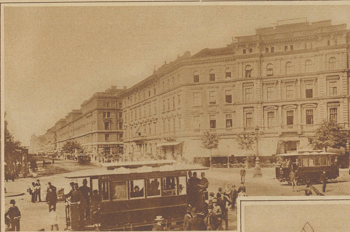
Die erste elektrische Straßenbahn mit unterirdischer Stromzuführung wurde vor 40 Jahren in Budapest in Betrieb genommen. Die Fahrlösung befindet sich im Schlitzkanal der Schienen.
