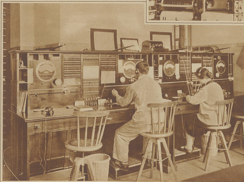
Bild rechts: Prüfstände im Störungsbureau. Entgegennahme von Störungsmeldungen. Prüfung und Messung von gestörten Teilnehmeranschlüssen
