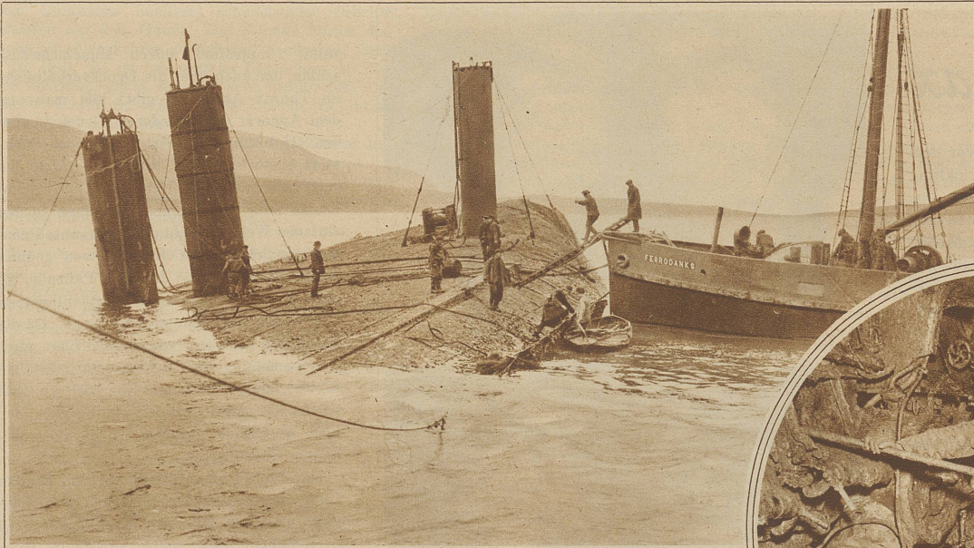
Das gehobene kieloben schwimmende Schiff mit den drei auf dem Rumpf montierten Pumpzylindern
