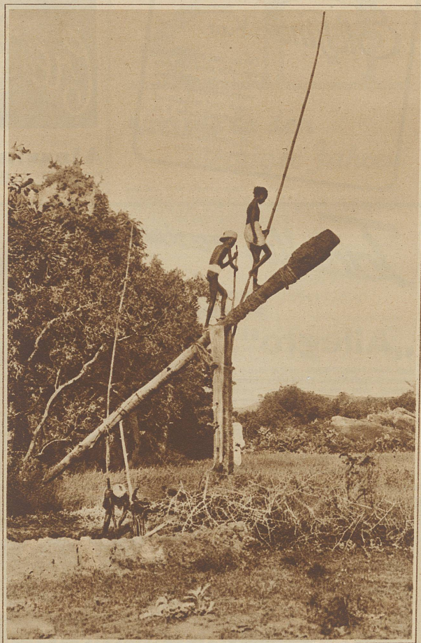
Noch primitiver ist die Methode der Hindus. Die beiden Männer heben durch ihr Gewicht den gefüllten Wasserkübel aus dem Sodbrunnen
