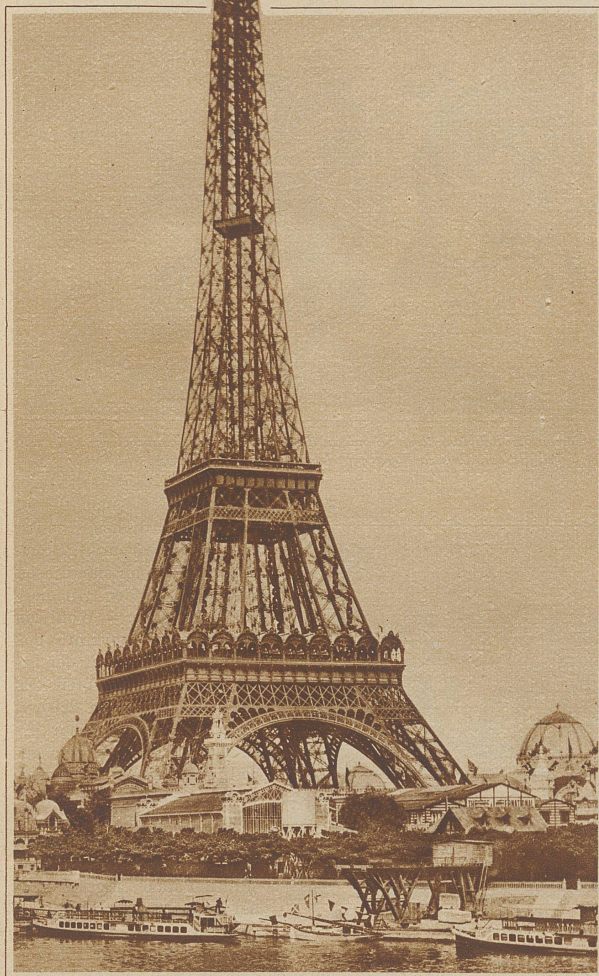
Eiffelturm, erbaut in den Jahren 1887-89 vom Pariser Ingenieur Gustave Eiffel. Höhe 300 m. Der Unterbau des Turmes ruht auf Betonklösten von 676 m² Grundfläche. Der Turm wiegt 9 Millionen kg. Die erste Plattform liegt 57,63 m, die zweite 115,73 m über dem Erdboden. Bis zur Spitze führen 1792 Stufen
