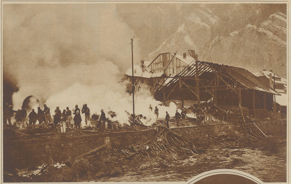
Ein Großfeuer äscherte am Montag einen Teil der Parkett- u. Chaletfabrik Interlaken ein. Der Schaden beträgt etwa 500000 Franken Phot. D'Aguzzo
