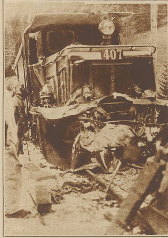
Eine der demolierten Lokomotiven
