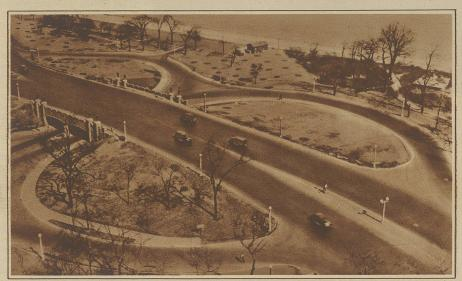
Die erste Schleifen-Autostraße wurde durch den Lincoln-Park in Chicago gebaut. Diese schleifenförmigen Auschweichstraßen erlauben das Abschwenken in eine Seitenstraße nach links, ohne daß die Fahrbahn entgegenkommender Wagen gekreuzt werden muß
