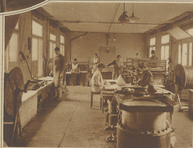
Bild links: Kerzengießmaschinen. Ziehen, Gießen und Stutzen von Weihnachtskerzen. — Phoi. Lienhardt
