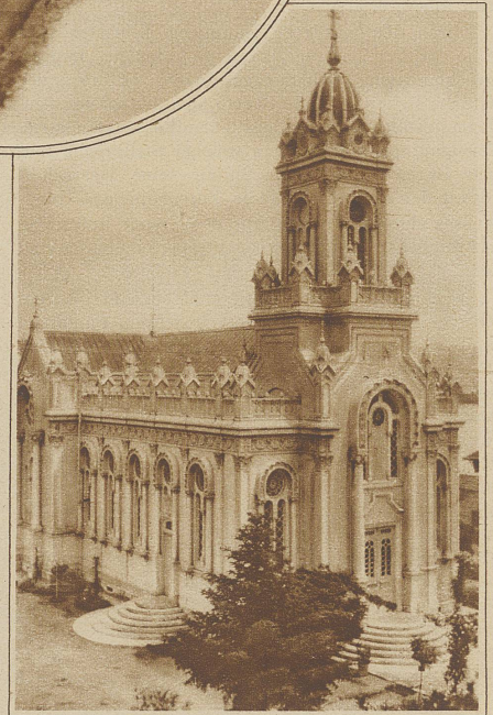
Eine eiserne Kirche. Die bulgarische Kirche «Sveti Stefan» in Konstantinopel ist ganz aus Eisen erbaut. Das einzigartige Bauwerk wurde vor 35 Jahren von einem österreichischen Architekten entworfen. Alle Teile wurden in Wien hergestellt und in einigen tausend Kisten verpackt nach Konstantinopel gesandt. Auf dem kleinen Friedhof neben der Kirche befindet sich das Grab des Bischofs Ilarion Mariopolski, des Vorkämpfers für die Befreiung Mazedoniens
