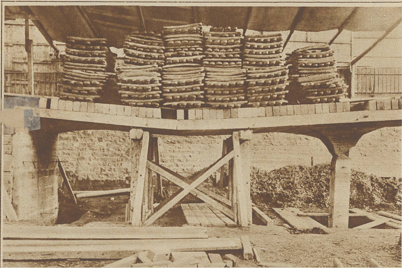
Wirkung der Belastung auf die Probekonstruktion
