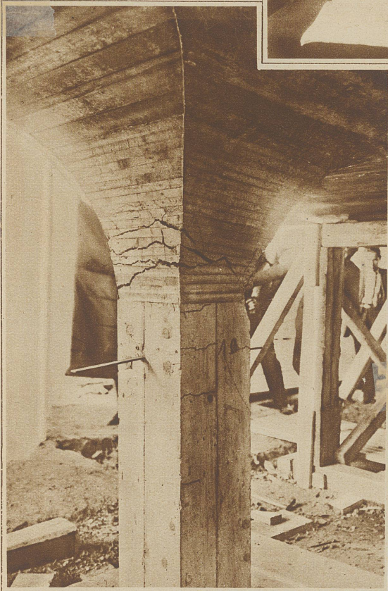
Durch die Ueberlastung erzeugte Risse im Betonpfeiler der Probekonstruktion
