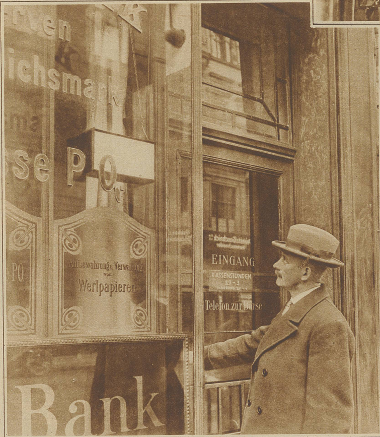
Die Deutsche Bank in Berlin hat eine Anlage für Einbruchs- und Ueberfallsicherung anbringen lassen. Wenn jemand gewaltsam eindringt, ertönt eine Sirene (oben im Bilde) und auf einem Leuchtkasten erscheinen die Worte «Hilfe - Ueberfall»
