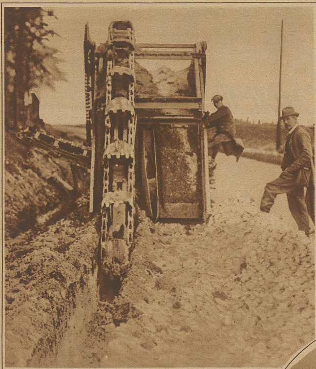
Eine neuartige Grabenmaschine, die in einer Stunde die gleiche Arbeit verrichtet, wie 50 Mann im Tag. Die Maschine wirft 40 cm breite und bis 1,20 Meter tiefe Gräben aus
