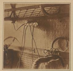
Radio im Eisenbahnzug. Von Budapest aus sind die ersten mit Zugradio ausgerüsteten Eisenbahnwagen in Zirkulation geseht worden. Jeder Sih hat, wie ein Blick in das aufgenommene Abteil zeigt, Kopfhörer, die gegen geringes Entgelt gemietet werden können
