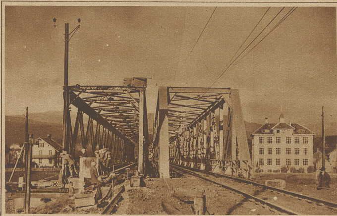
Die neue Brücke ist dem Verkehr übergeben worden; links daneben die weggeschobene alte Brücke
