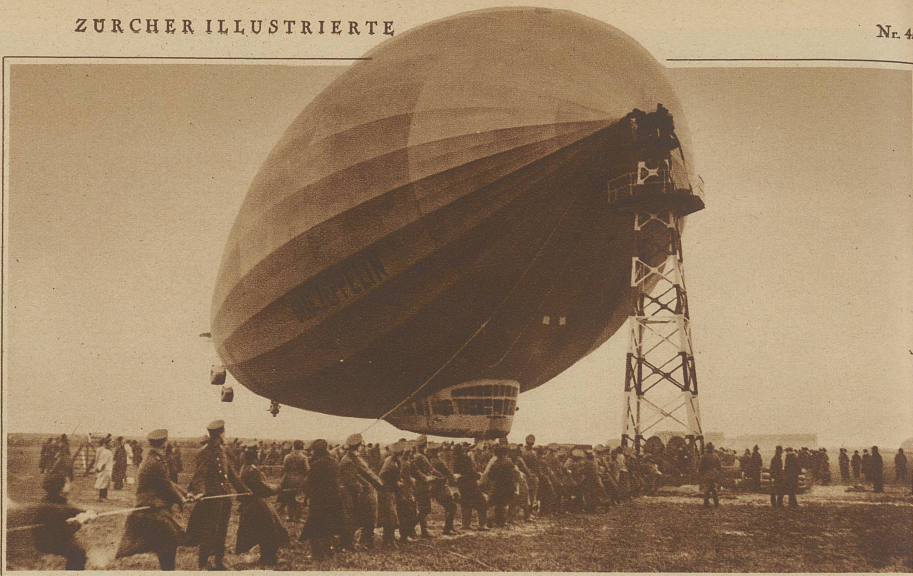
Verankerung des Luftschiffes am Ankermast in Staaken bei Berlin
