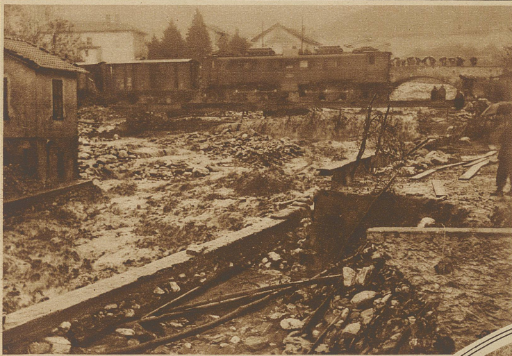
Die Das Geschiebefeld des vom Monte Arbino herunter kommenden Wildbaches Hochwasserverheerungen an der Gotthardbahn bei Molinazzo Bild rechts (im Oval): Die von den Bundesbahnen erstellte Notbrücke liegt etwa 2 m höher als die alte Trasse, an deren Freilegung gearbeitet wird
