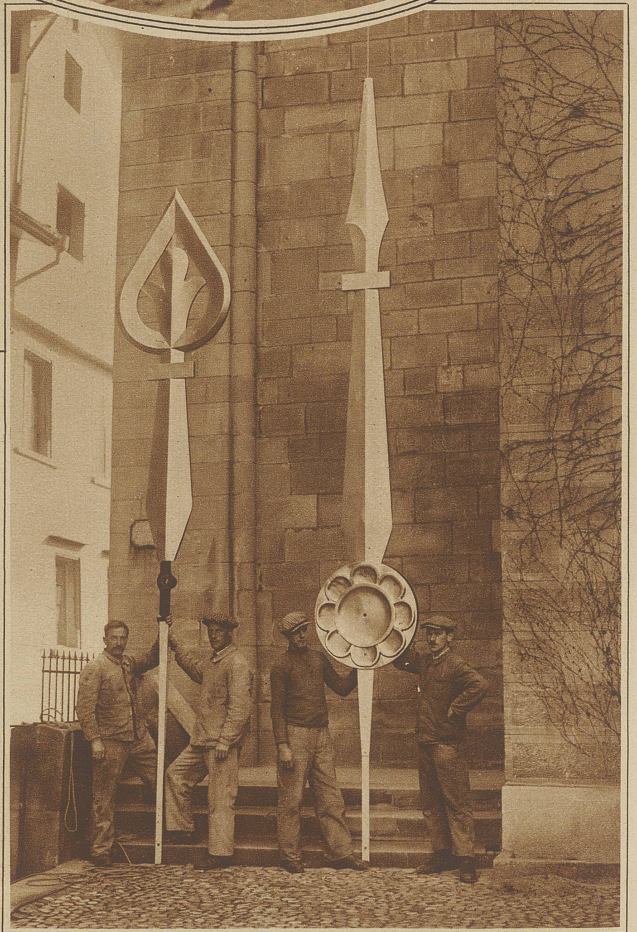
Montieren der Zeiger. Das Zifferblatt ist mit einem Durchmesser von annähernd 9 m das größte in Europa
