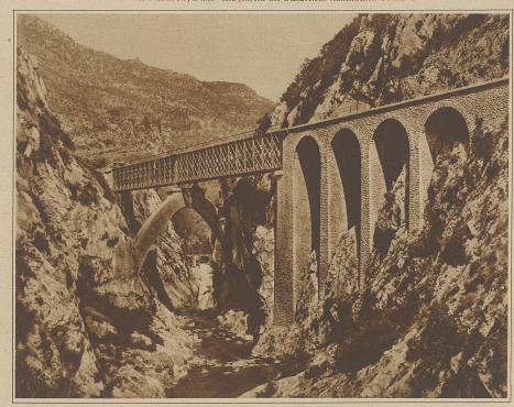
Brücke über die Bévéra. Das Bett des Wildbaches ist so eng, daß es die Errichtung eines Zentralpfeilers nicht erlaubte. Die steinernen Bogen wurden daher durch eine Metallkonstruktion verlängert, die sich auf den Scheitel eines die beiden Wände der Schlucht verbindenden gemauerten Spitybogens stütt
