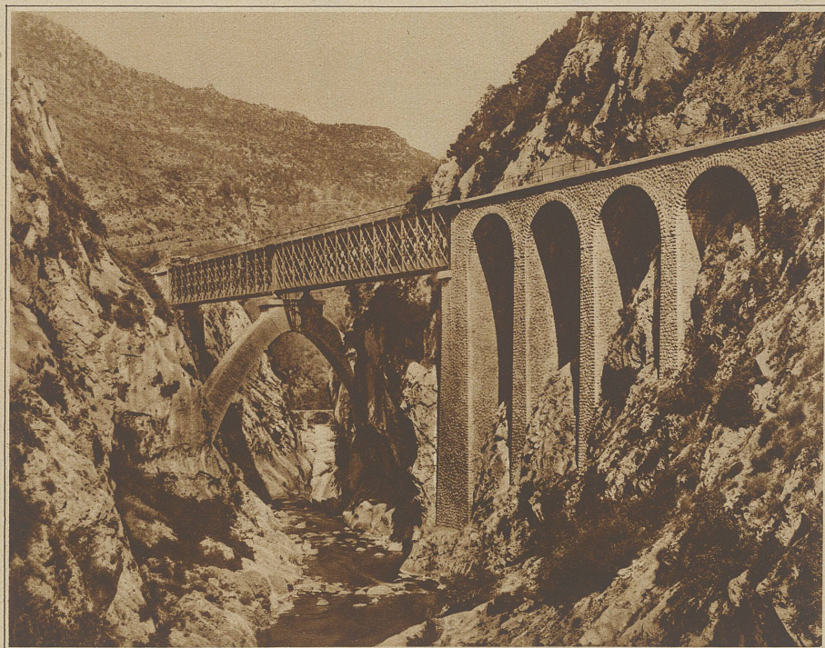
Brücke über die Bévère. Das Bett des Wildbaches ist so eng, daß es die Errichtung eines Zentralpfeilers nicht erlaubte. Die steinernen Bogen wurden daher durch eine Metallkonstruktion verlängert, die sich auf den Scheitel eines die beiden Wände der Schlucht verbindenden gemauerten Spitzbogens stützt
