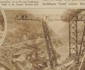
Die Doppelseilbahn fördert das aus dem Aarboden herzugeführte Kies- und Sandmaterial aus der Grobbrecherei zu der hochliegenden Sortier- und Betonieranlage auf dem Nollen
