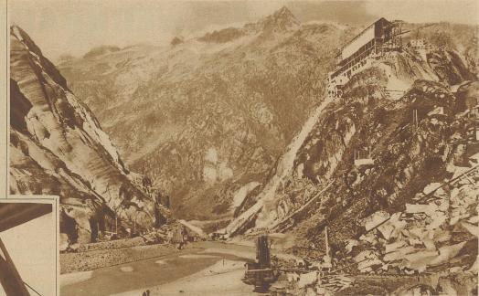
Blick durch die Spitallamm hinab, die durch eine 115 m hohe, an der Sohle 68 m, auf der Krone 4 m dicke Sperrmauer von 340,000 Kubikmeter Masse verriegelt wird
