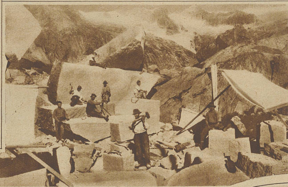
Der gesunde Grimselgranit liefert an Ort und Stelle das Material für die Mauerkrone und den Wasserüberfall der Gelmersperr
