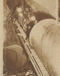
Vermittelst einer Standseilbahn werden die neun Tonnen schweren Druckrohre von der Handeck zum Gelmersee hinaufbefördert
