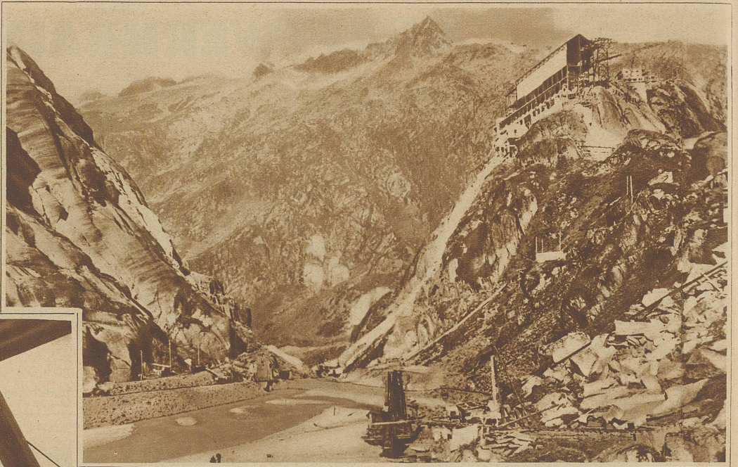
Blick durch die Spittalamm hinab, die durch eine 115 m hohe, an der Sohle 68 m, auf der Krone 4 m dicke Sperrmauer von 340,000 Kubikmeter Masse verriegelt wird
