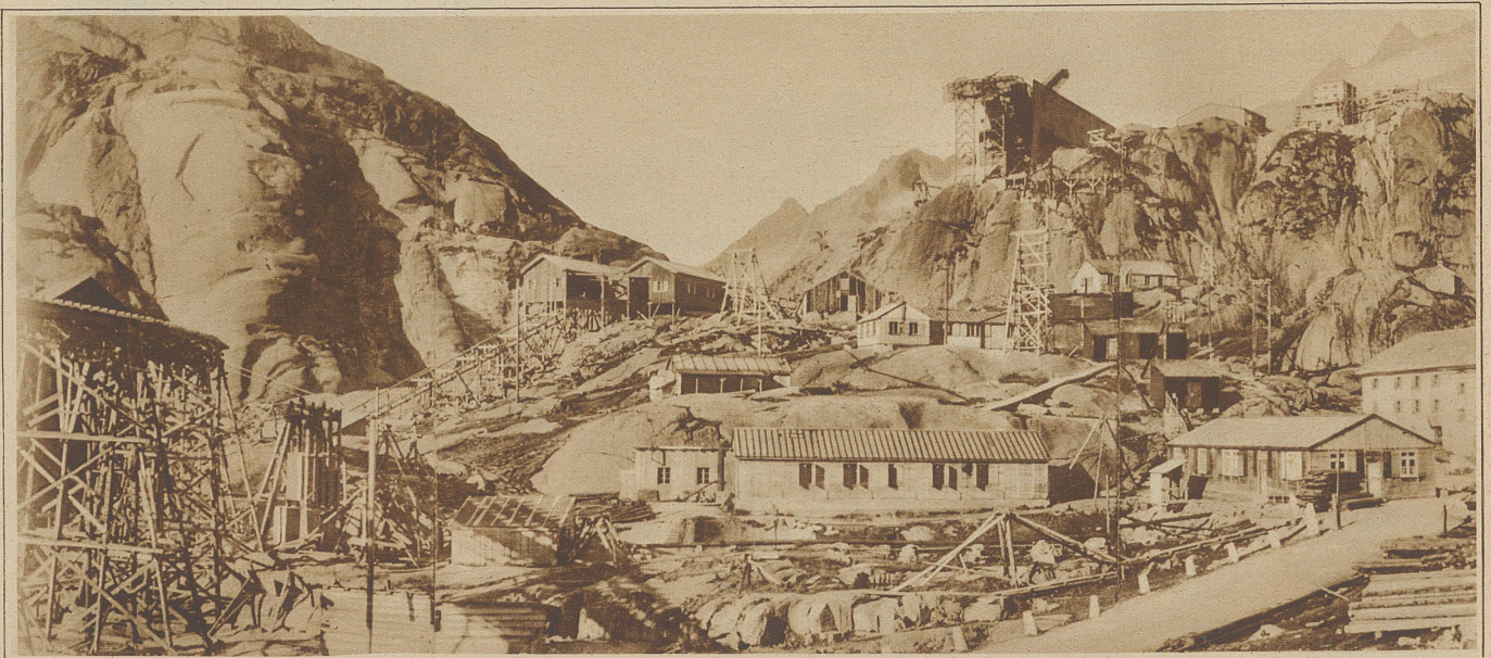
In das Barackendorf am Spitalnollen führt von links die gerüstverstreute Materialbahn aus dem Aarboden. Nach der Grobverarbeitung in der Brecherei befördert eine Doppelseilbahn das Material in die Sortier- und Betonieranlage auf dem Nollen. Rechts das alte Hospiz an der Grimselstraße, auf dem Nollen das neue Wärterhaus und das soeben eröffnete neue Grimselhospiz
