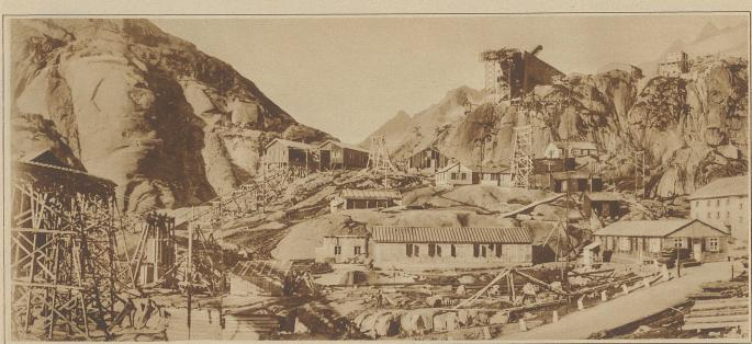
In das Barackendorf am Spitalnollen führt von links die gerüstverstrebte Materialbahn aus dem Aarboden. Nach der Grobverarbeitung in der Brecherei befördert eine Doppelseilbahn das Material in die Soriier-Betonieranlage auf dem Nollen. Rechts das alte Hospiz an der Grimselstraße, auf dem Nollen das neue Wärterhaus und das soeben eröffnete neue Grimselhospiz
