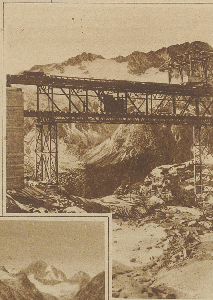
Zum Bau der 380 m langen Gelmersperre, die den Spiegel des Gelmerees um 30 m erhöhen und damit dreizehn Millionen Kubikmeter Stauroum schaffen wird, sind die Geleise der Materialtransportbahn auf die Eisengerüste gelegt worden, die mit einbetoniert werden
