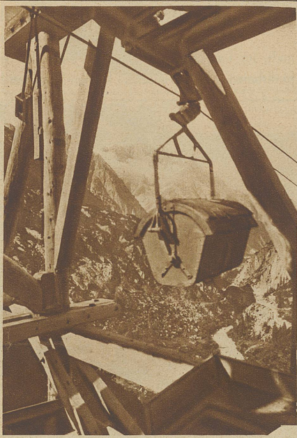
Der Zementtransport aus dem Tal herauf vollzieht sich vermittelst eiserner Transportkübel, die an die Luftseilbahn gehängt werden, welche das ganze obere Aaretal durchzieht
