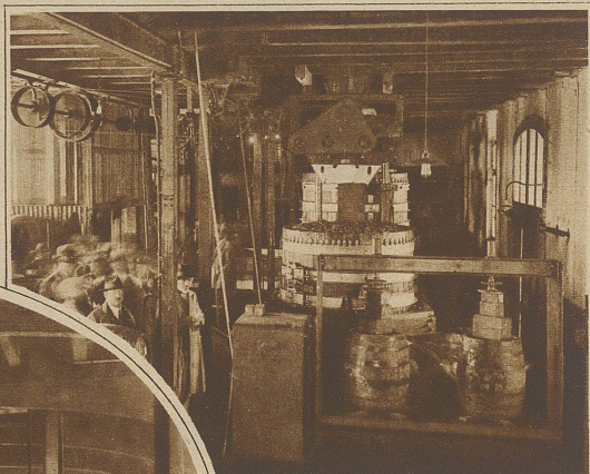
Mosterei Egnach. Vor den Pressen steht eine Fabreinreinigungsmaschine
