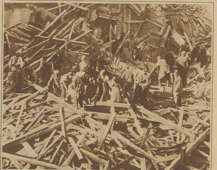
Die Einsturzkatastrophe in Prag. In Prag stürzte ein siebenstöckiger Neubau ein. Von den 90 am Bau beschäftigten Personen sind bisher 33 Tote und 37 Verwundete geborgen worden. 20 Personen werden noch vermißt; sie sind wohl ebenfalls zu den Toten zu zählen, da die aus den Trümmern vernommenen Klopf-signale aufgehört haben
