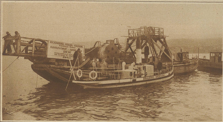
Auslegen der Kabel am Ufer bei Erlenbach
