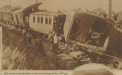
bedeutend. Das Unglück entstand dadurch, daß der eine Zug auf der Station die Kreuzung des Gegenzuges nicht abwartete und so in einer un= übersichtlichen Kurve auf diesen stieß
