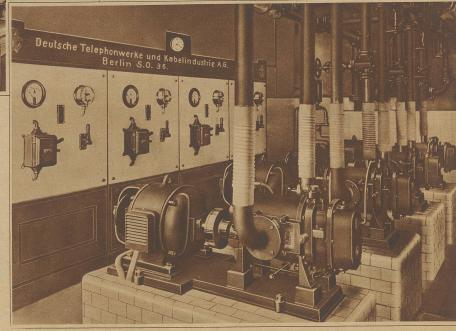
Die Gebläseanlage treibt die Rohrpostpatronen durch die Fahrrohre
