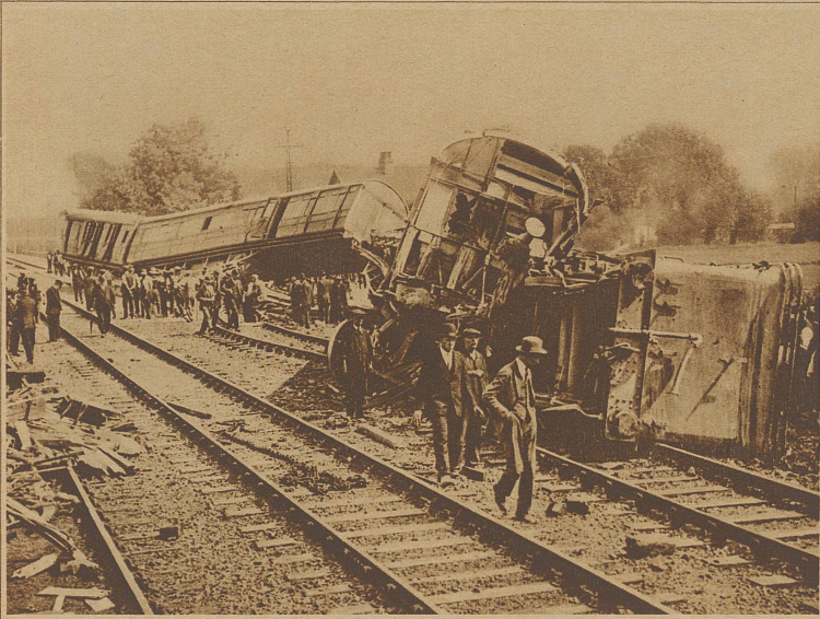
Zusammenstoß zwischen Eisenbahn und Autocamion.
