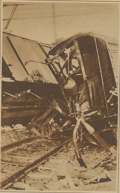
Zugsentgleisung im Bahnhof Wollishofen. Am Donnerstag früh entgleiste auf der Station Wollishofen bei der Einfahrtsweiche ein Güterzug aus der Richtung Zürich. Außer der Lokomotive wurden 15 Wagen aus dem Geleise geworfen, wovon vier völlig ineinandergeschoben und zertrümmert wurden. Personen wurden keine verletzt, denn auch der Zugführer, der sich im Moment der Entgleisung auf dem Bremsis eines völlig zertrümmerten Wagens befand, kam wie durch ein Wunder ohne die geringste Verletzung davon. Degegen ist der Materialschaden bedeutend
