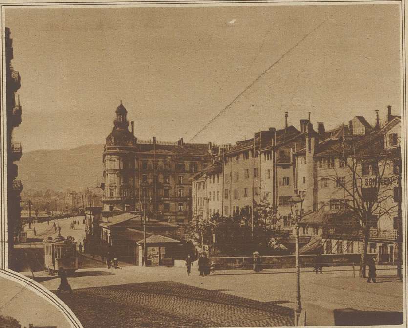
Die Rämistrasse im Jahre 1888 mit dem Baugespann der Denzler-Häuser
