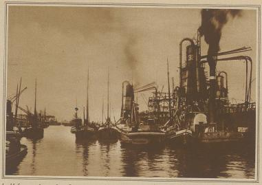
lm Hafen von Amsterdam. Das große Hebewerk rechts im Bilde dient zum Verladen des Getreides auf die Binnenschiffahrts-Kähne
