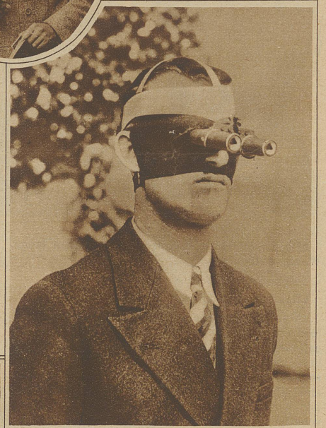
Unten: Eine für besondere Zwecke praktische Erfindung ist von einem Amerikaner gemacht worden. Der Feldstecher kann in Zukunft vor die Augen geschaltet werden, so daß man ihn nicht mehr mit den Händen festzuhalten braucht
