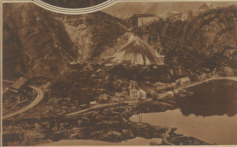
Titaneuwerk im Grimselgranit. Durch einen massiven Damm quer über die Aarlam wird das Gebiet des Unteraarbodens und der beiden Grimselseen überstaut; das alte Grimselhospiz im Vordergrund muß geopfert werden, denn der Stauseespiegel erreicht die Höhe des links sichtbaren Kreuzes. Rechts auf dem «Nollen» das neue Hospiz (Phot. Bürgi)
