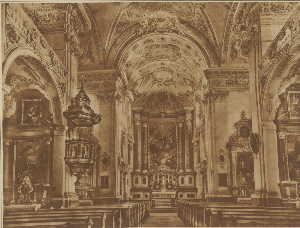
Die in den Jahren 1680–1687 erbaute Jesuitenkirche in Solothurn ist vom Zerfall bedroht. Ihre Rettung bereitet den Behörden schwere Sorgen
