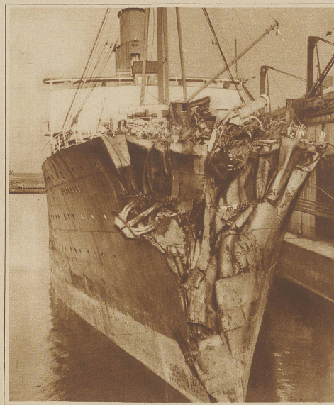
Ein Dampfer rammt einen Eisberg. Der 16000-Tonnen-Dampfer «Montrose» lief dieser Tage mit vollständig eingedrücktem Bug, der dem zerbeulten Balg einer Ziehharmonika glich, in Liverpool ein. Das Schiff hatte einen Zusammenstoß mit einem Eisberg gelitten. Passagiere und Besatzung können nicht genug die Kaltblütigkeit des Kapitäns Landy rühmen, der sie ihre Rettung aus höchster Gefahr zu danken haben. Das Schiff hatte im dichten Nebel plötzlich einen Eisberg gesichtet. Dem Kapitan gelang es, dem Ungetüm auszuweichen, da aber gleichzeitig ein zweiter, kleinerer Eisberg auftauchte, sah er sich gezwungen, zwischen zwei Übeln das kleinere zu wählen und beschloß daher, mit Volldampf gegen den kleinen Eisberg anzurennen. Durch den Anprall wurden alle 178 Passagiere des Schiffes zu Boden geworfen. Zwei Matrosen wurden getötet. Der Zusammenstoß war furchtbar; er glich dem Donner eines Kanonenschusses, und ein Berg von Eis und Schnee stürzte auf das Schiff.
